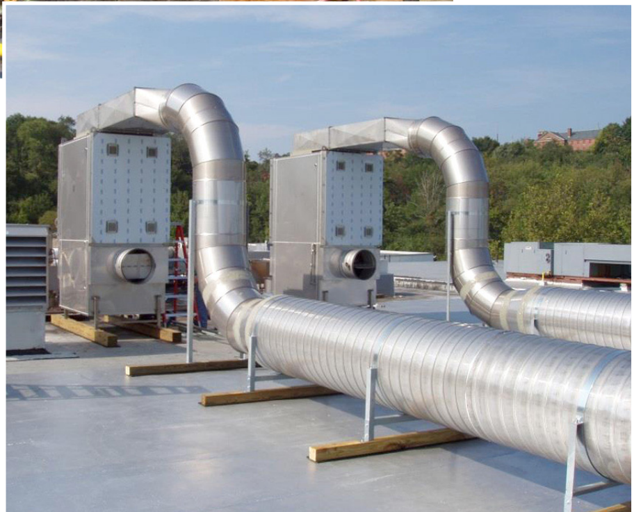
Depois da instalação
