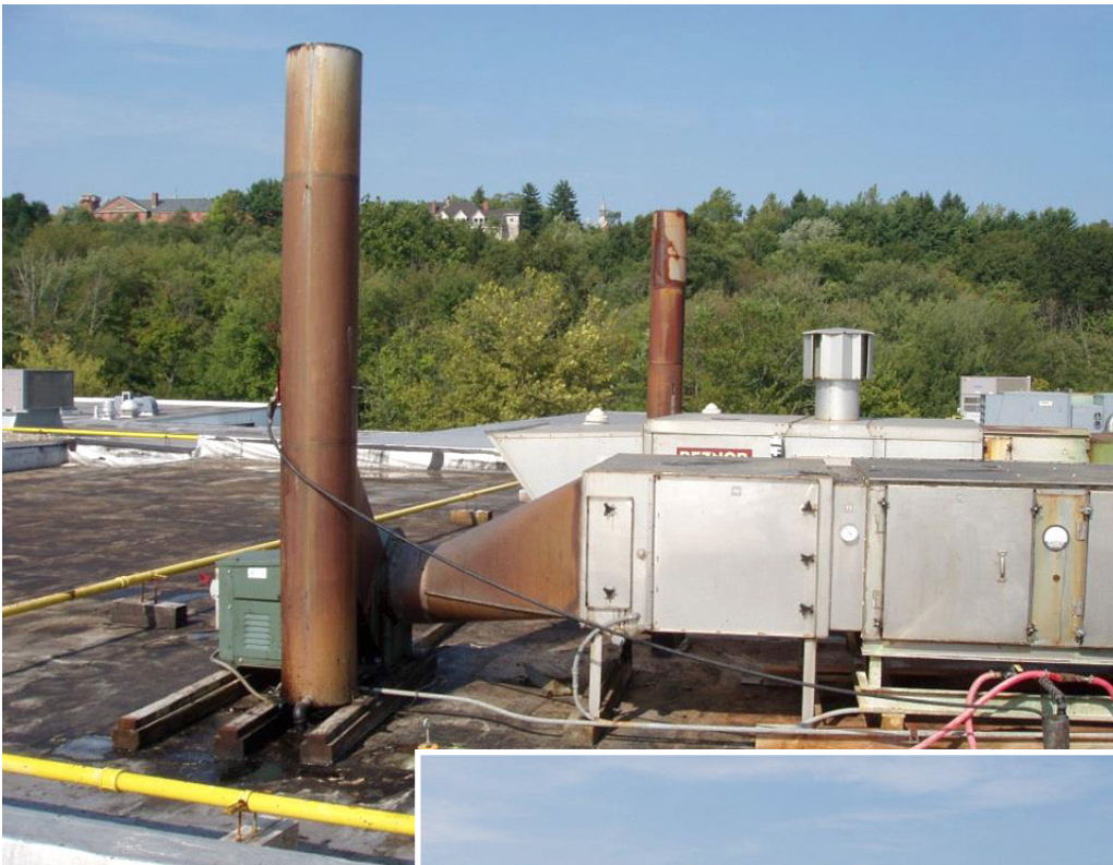
Antes de la instalación
