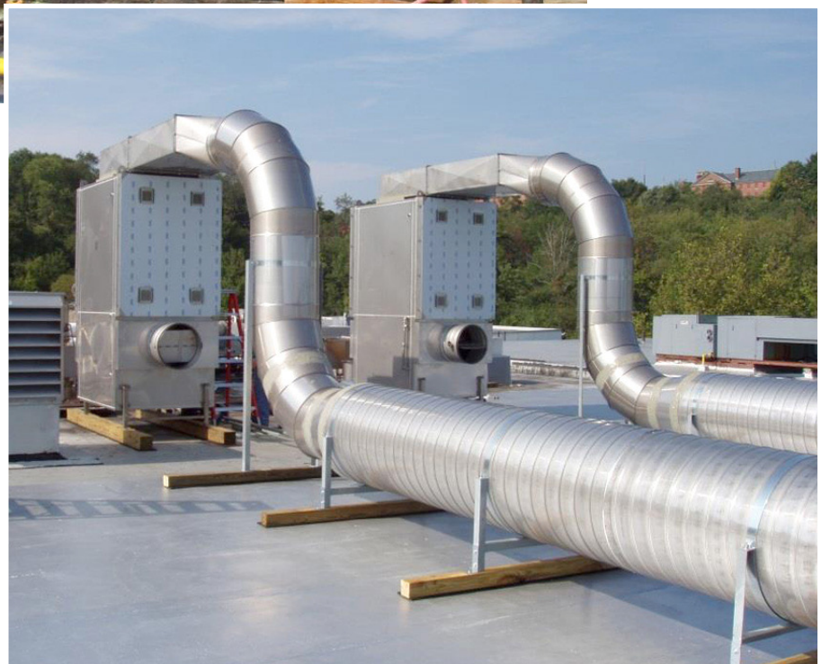
Después de la instalación
