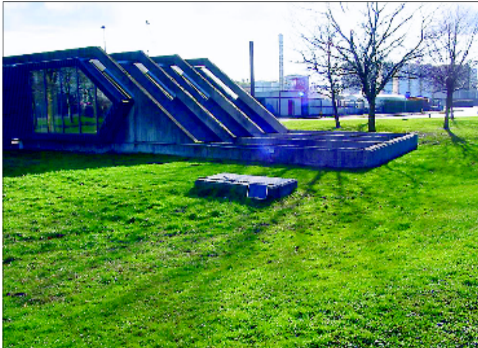
Luftgenerne på Fredericia Centralrenseanlæg blev elimineret med et luftrenseanlæg fra Jimco A/S.
